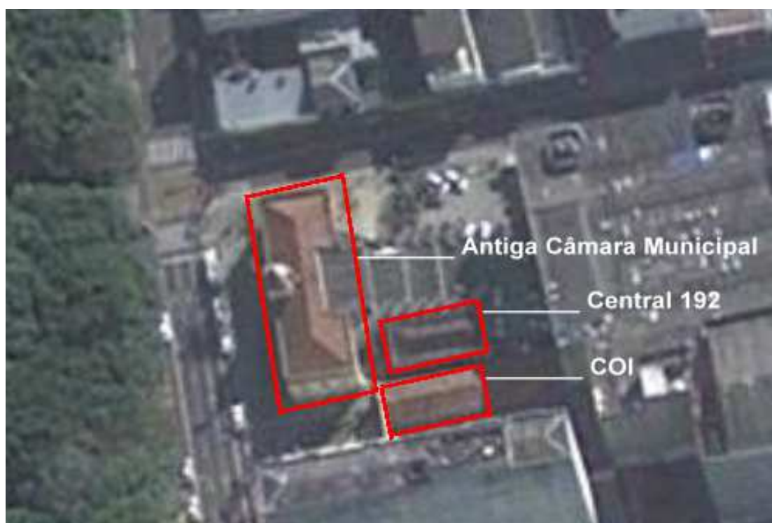
Vista aérea das áreas do COI e da futura Central 192 mostrando a independência estrutural entre elas
